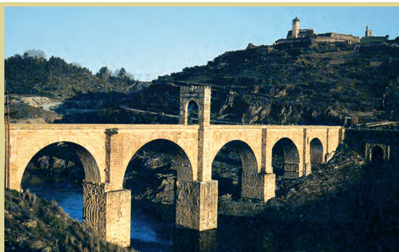
FIGURA 1 - PONTE ROMANA DE ALCANTARA (CÁCERES)
