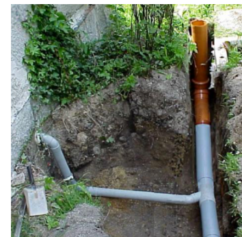
Perfuração efetuada através de vala exterior
