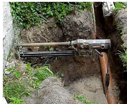
Perfuração efetuada através de vala exterior
