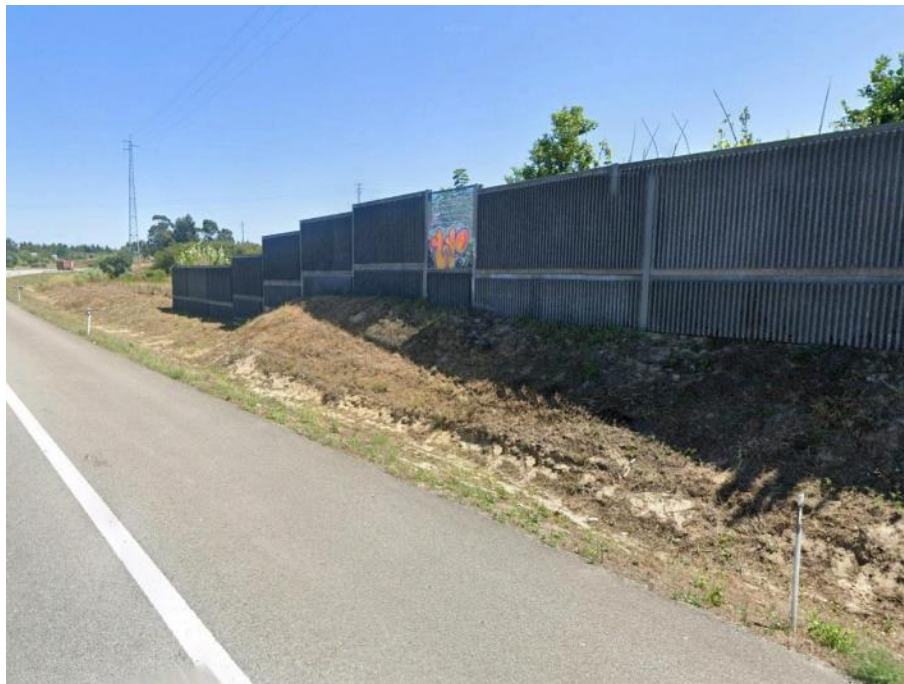
Figura 7: Barreira de Betão.
