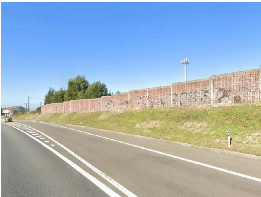
Figura 6: Barreira de Blocos.
