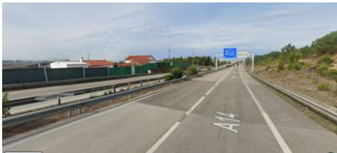
Fig.4 - Exemplos de barreiras acústicas existentes na A14
