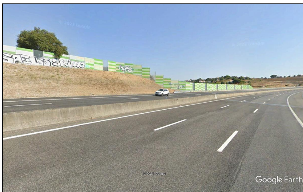
Figura 4-5 – Exemplos de barreiras acústicas instaladas na A10
