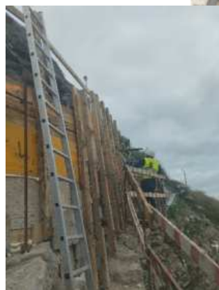
Fotografia 2 – Execução de cofragens
