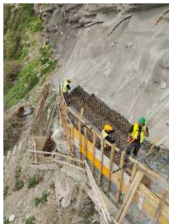
Fotografia 1 – Execução das armações de ferro
