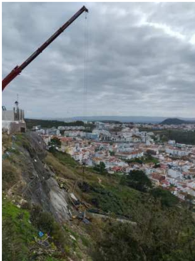
Foto 1 – Vista Geral da Frente de Trabalhos no Pano do Talude
