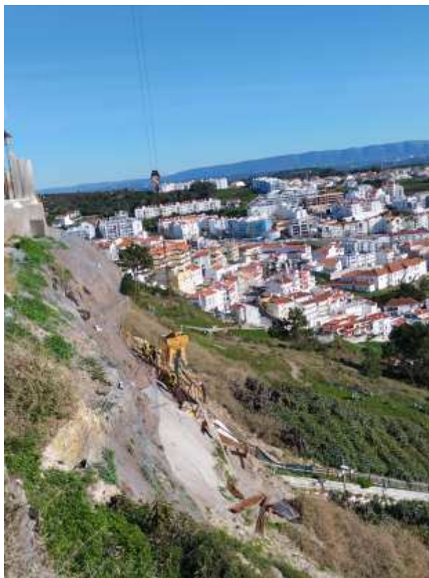
Foto 4 – Betonagem da Viga de Betão Armado Inferior 1ª Fase
