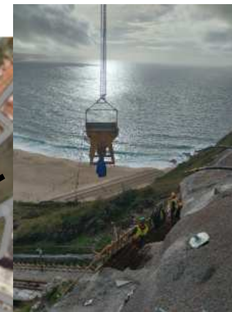
Fotografia 3 – Betonagem da viga inferior
