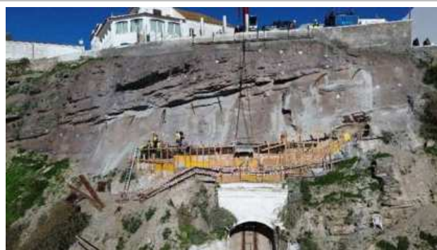
Frente de obra da plataforma Superior do Ascensor – Trabalhos de execução das cofragens da viga inferior (primeira fase de betonagem);
