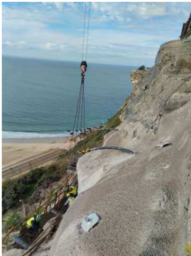
Foto 5 – Montagem de Armaduras da Viga de Betão Armado Inferior 2ª Fase
