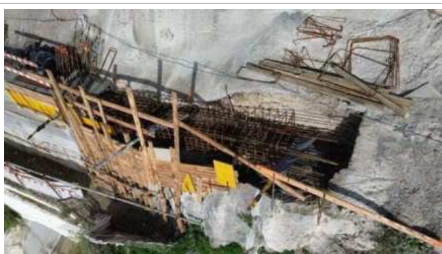
Frente de obra da plataforma Superior do Ascensor – Trabalhos de execução das armaduras da viga inferior (segunda fase de betonagem);
