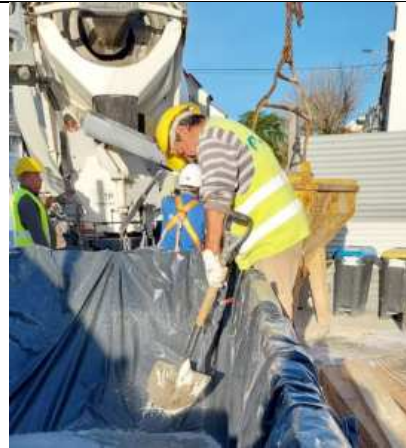
Fotografia 5 – Lavagem ferramentas de apoio à betonagem
