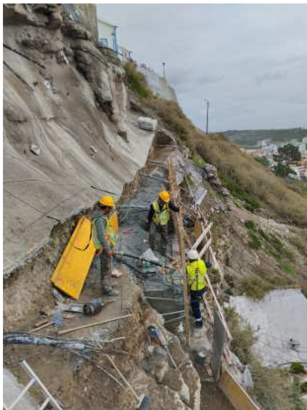
Foto 2 – Trabalhos de Implantação da Viga de Betão Armado Inferior
