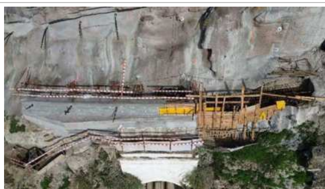
Frente de obra da plataforma Superior do Ascensor – Trabalhos de execução das cofragens da viga inferior (segunda fase de betonagem);
