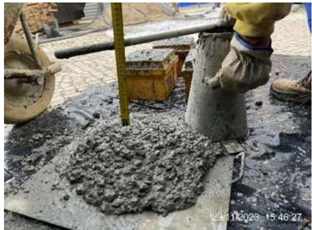
Frente de obra da plataforma Superior do Ascensor – Ensaio de Slump 29/11/2023 – GR P518/0083484;
