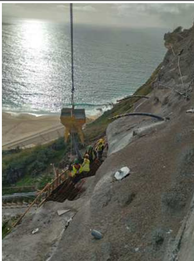
Foto 6 – Betonagem da Viga de Betão Armado Inferior 2ª Fase
