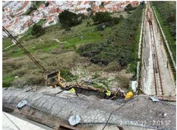
Frente de obra da plataforma Superior do Ascensor – Betonagem da segunda fase da viga inferior no dia 29/11/2023;
