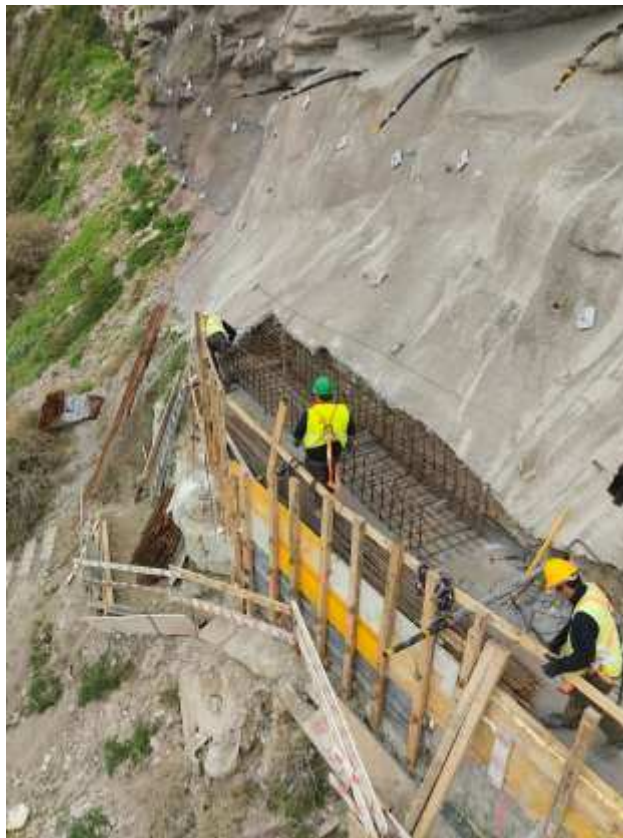
Foto 3 – Montagem de Armaduras da Viga de Betão Armado Inferior 1ª Fase
