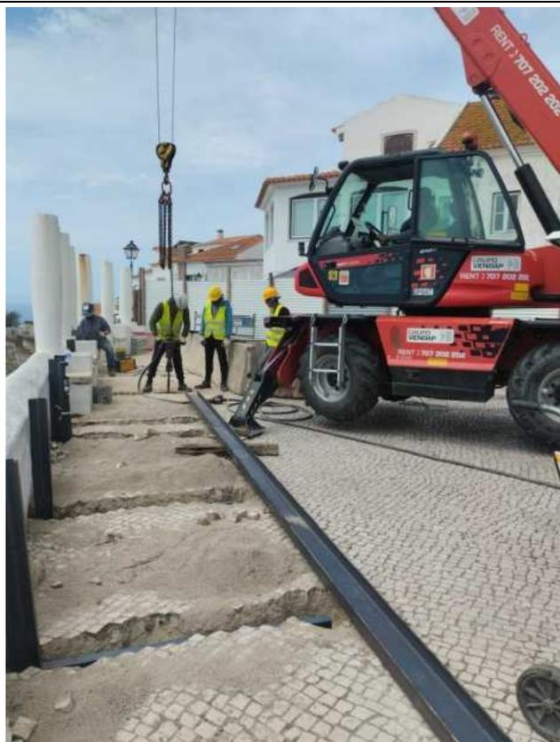
Foto 6 – Execução de trabalhos de contenção muro M1
