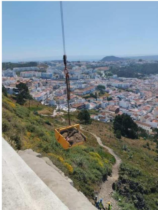
Foto 4 – Remoção de materiais soltos do talude
