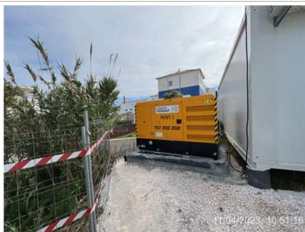
Construção da bacia de retenção e instalação do gerador de energia no estaleiro;
