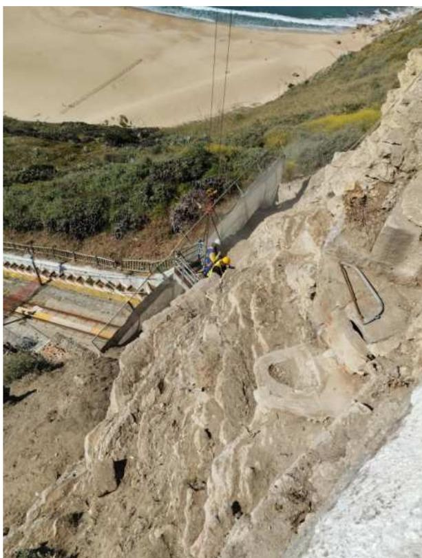
Foto 2 – Trabalhos de limpeza e remoção de materiais soltos do talude com recurso a Plataforma de Transporte de Pessoas
