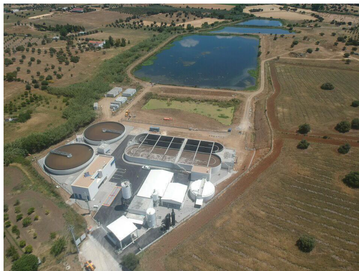
Figura 3 Vista aérea da nova ETAR de Beja (2019), serve 20 000 habitantes e cujo local de rejeição é a ribeira da Cardeira, afluente direto do rio Guadiana
