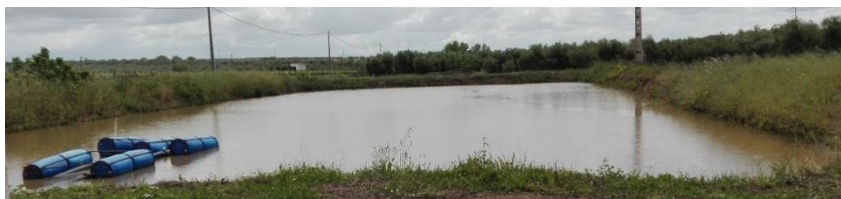
Figura 1 Charca intercessão com o nível freático
