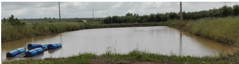
Figura 4 Captação de água subterrânea tipo Charca
