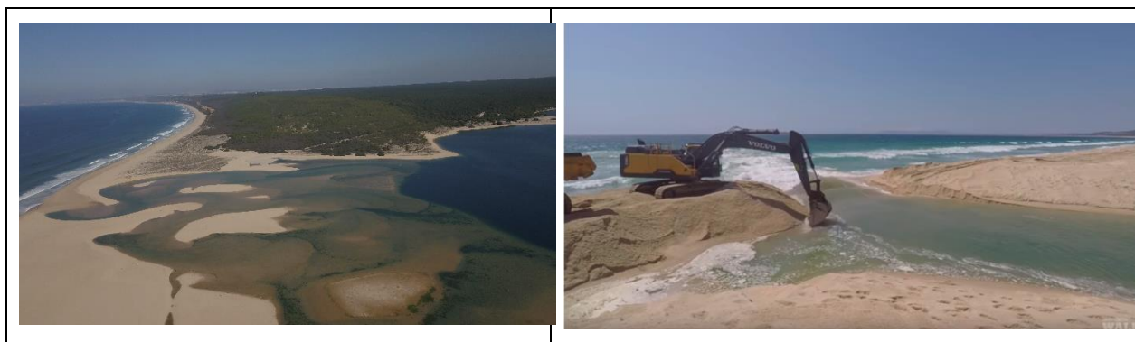
Figura 4 – Abertura da lagoa de Albufeira ao mar (2019).
