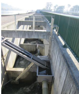
Foto 2 – pormenor da PPP e da pesagem de enguias do açude Ponte de Coimbra
