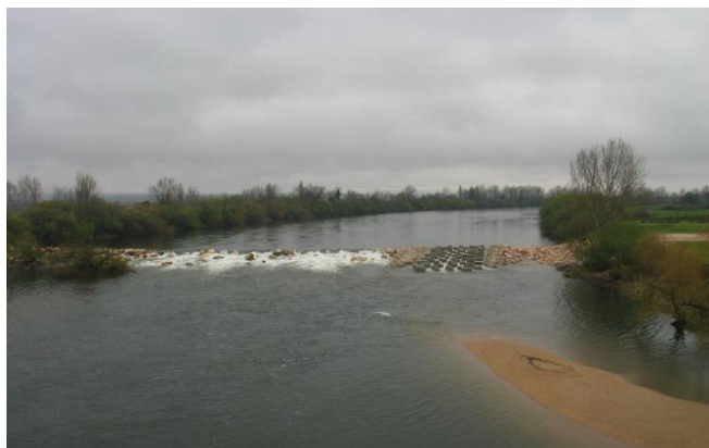
Açude de Formoselha (depois de implementada a passagem para peixes)
