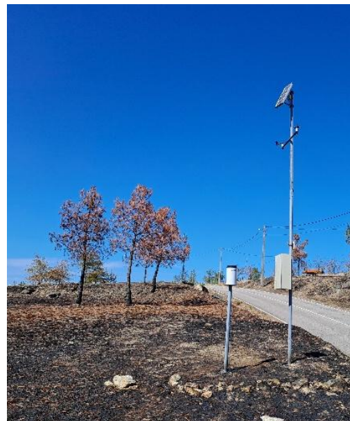
Figura 4- Estação udométrica da Lapa (RH4A) após incêndios de 2025, (SNIRH, 2025).
