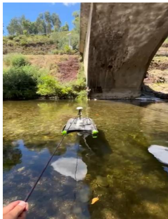
Figura 10- Equipamento de ADCP (Corda) na Ponte de Colmeal.
