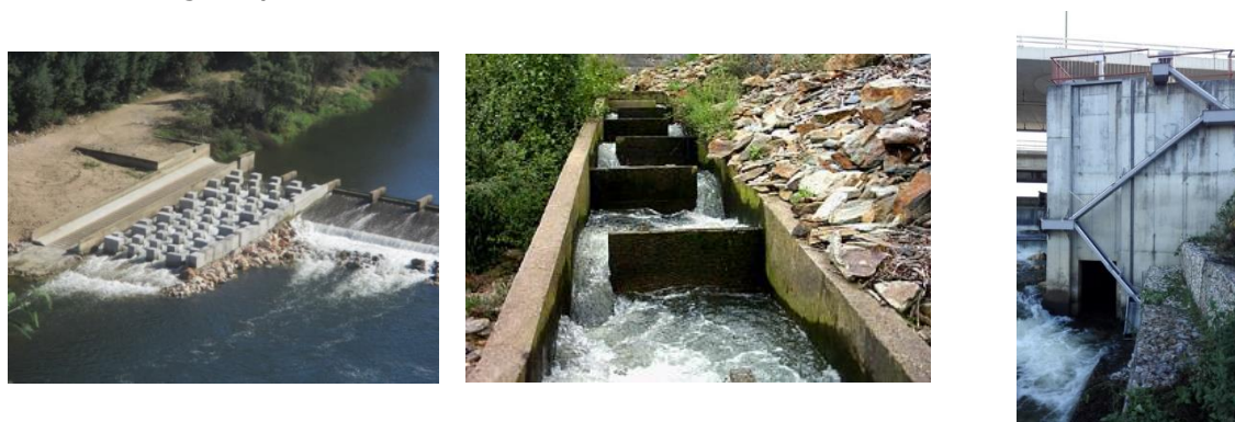
Figura 3.3 - Ilustração dos três tipos de passagens para peixes consideradas no ICF, correspondendo, da esquerda à direita, às identificadas acima por A a C
