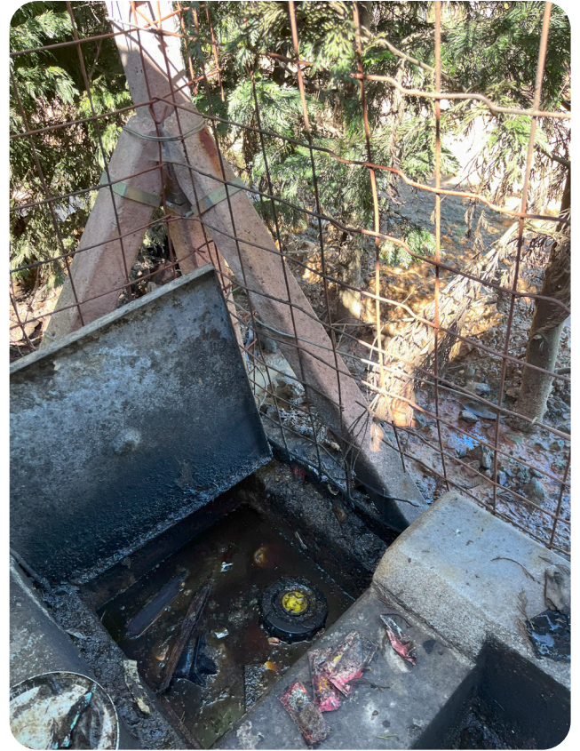
Murete de contenção de águas pluviais (caixa de visita de recepção e vista exterior das escorrências)
