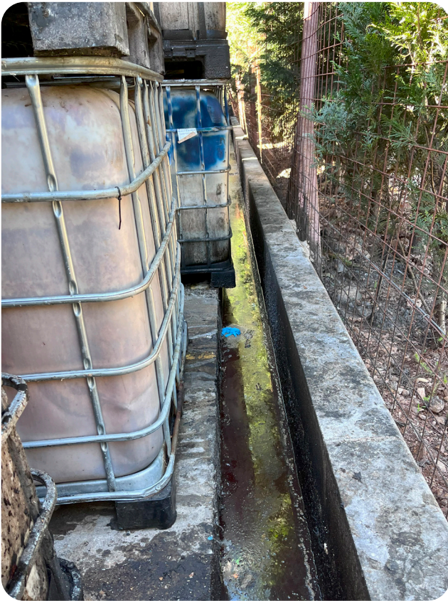
Murete de contenção de águas pluviais (caixa de visita de recepção e vista exterior das escorrências)
