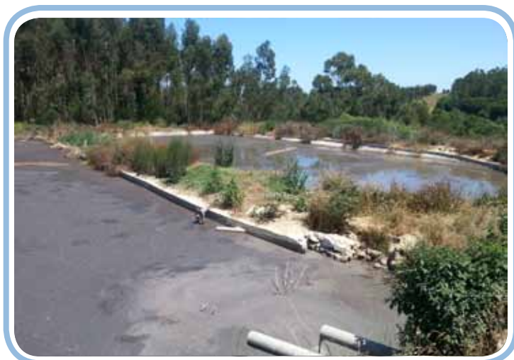
Foto 7 – Más condições de funcionamento e manutenção dos sistemas de armazenamento de efluentes
