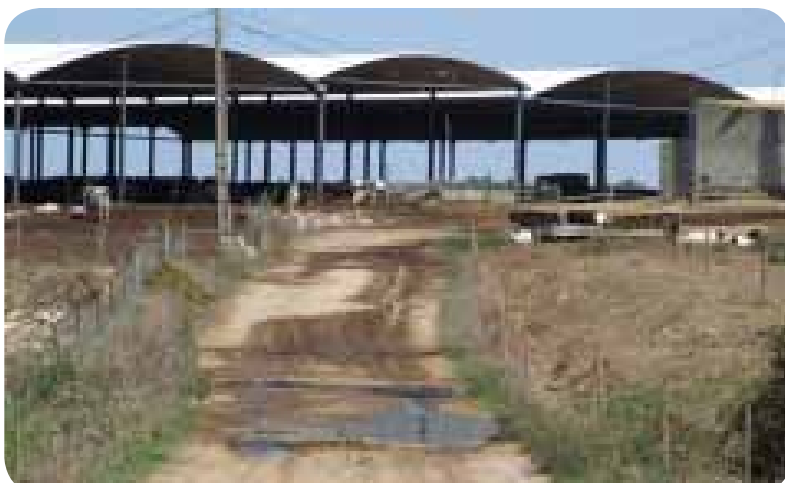
Foto 19 - Escorrências provenientes de exploração pecuária
