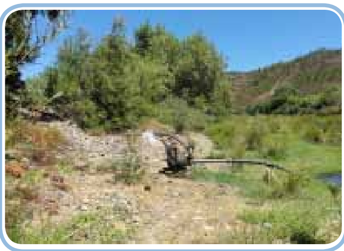
Foto 15 – Captação de água superficial na ribeira de Odelouca
