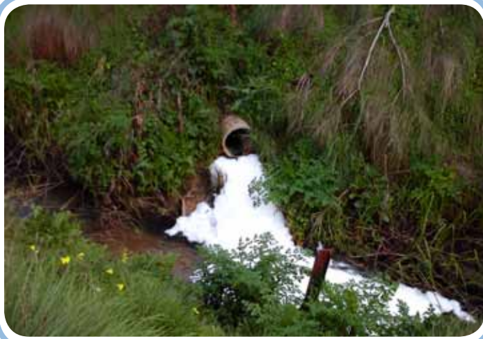
Foto 8 – Descargas ilegais na Ribeira do Sarra
