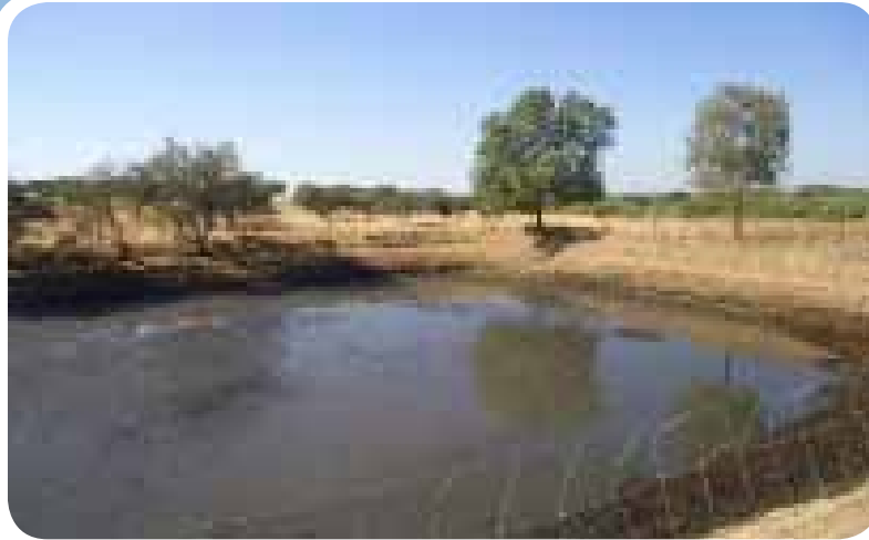
Foto 17 - Lagoa de armazenamento de efluentes pecuários
