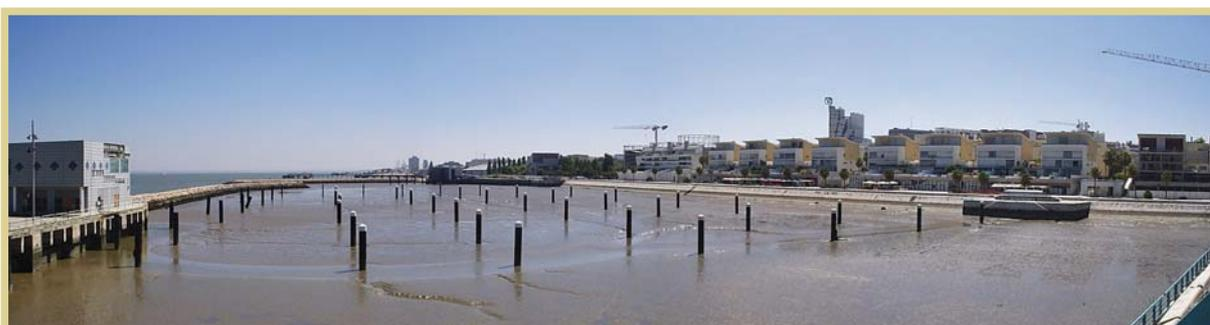
**FIGURA 1** - A Marina do Parque das Nações em situação de baixa-mar em 2007, sendo notória a condição de assoreamento então existente e que obrigou à realização de um complexo projecto de requalificação.
