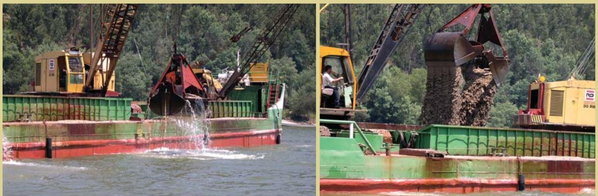
**FIGURA 2** - Operações de dragagem em meio fluvial
