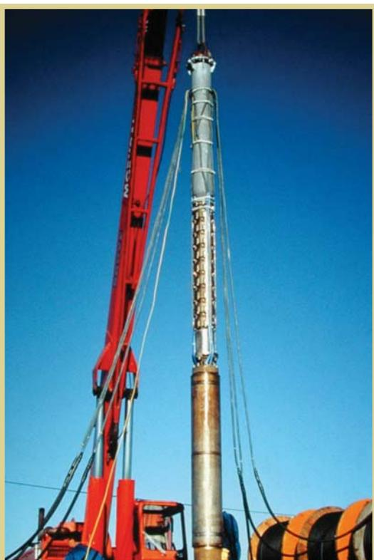
**FIGURA 4** - Instalação de equipamento de extração em sondagem profunda (Foto: Canal de Isabel II)
