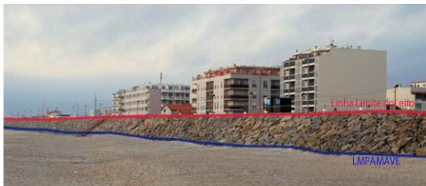
Fig. 12- Representação da LMPAVE e da Linha Limite do Leito pela base e crista da defesa aderente respetivamente, na Praia da Vagueira - Vagos ( Foto CEDRU)
