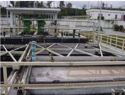
*Figura 10: Flotador*
