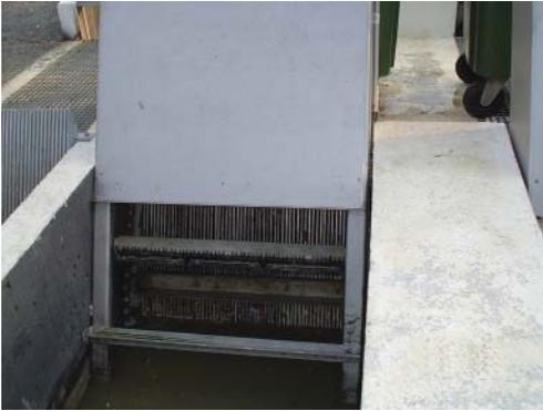
*Figura 5: Grade mecânica*
