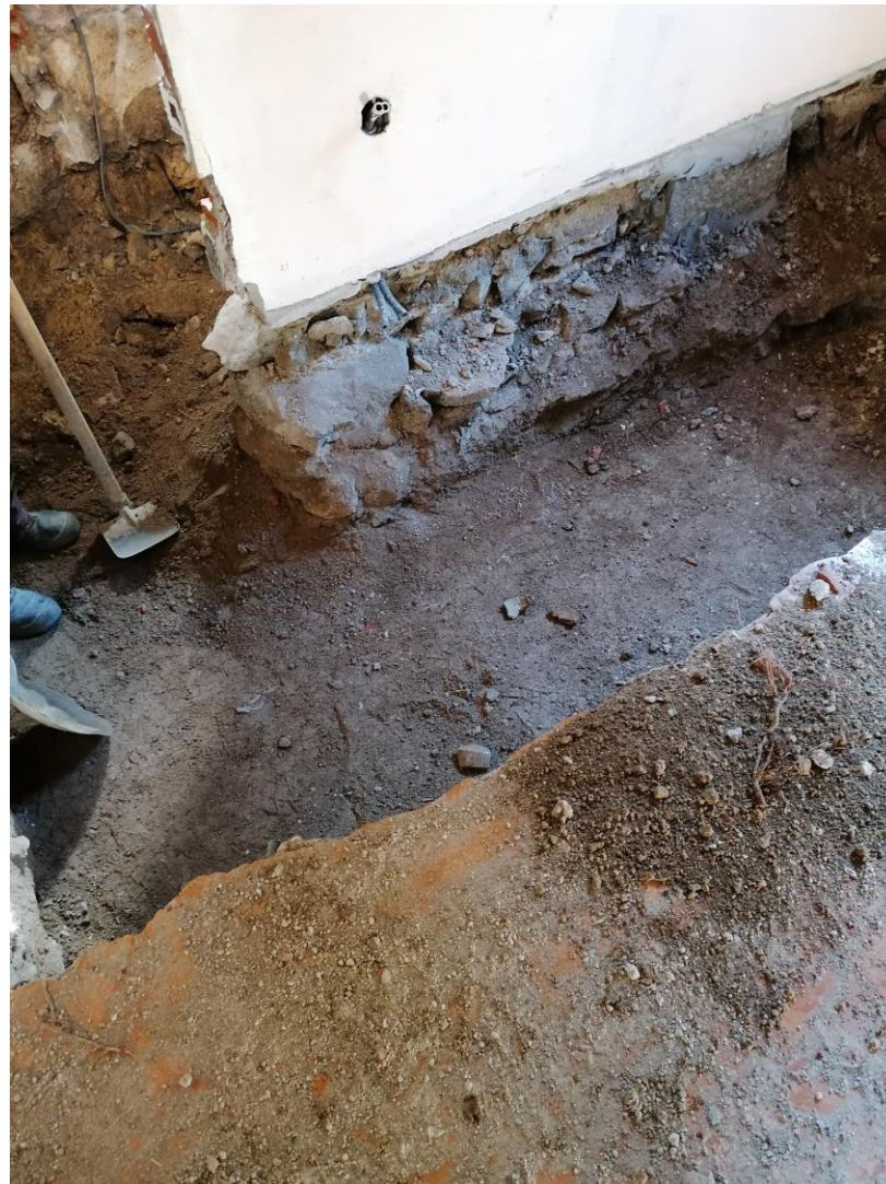
Escavação para Mitigação
