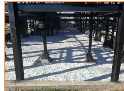
Preparação da camada de acabamento final (betonilha reforçada)
