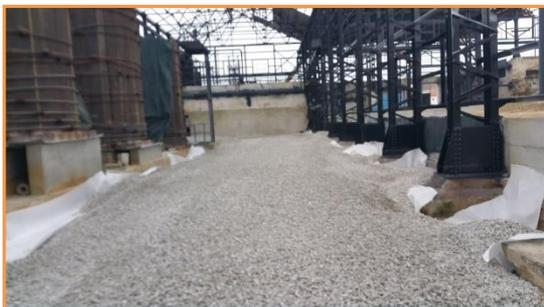
Camada de brita com mínimo de 0,30m de espessura
