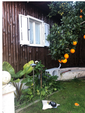
Detetores no exterior. Imagens cedidas pelos autores.
