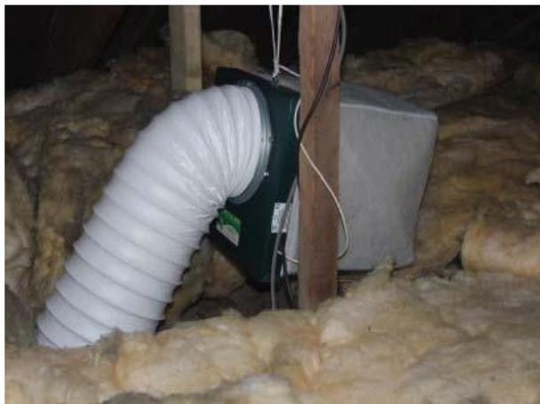
Figura AIII.2 – Sistema de ventilação por pressurização montado no desvão da cobertura<sup>13</sup>
