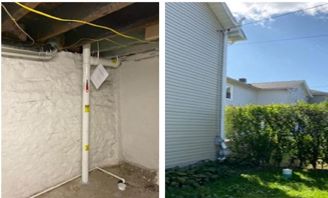
Figura AIV.5 – Vistas de conduta de exaustão situada no interior (à esq.) e no exterior (à dir.) de sistemas de depressurização do terreno debaixo do pavimento, ambos com a saída de exaustão ao nível da cobertura<sup>18</sup>
