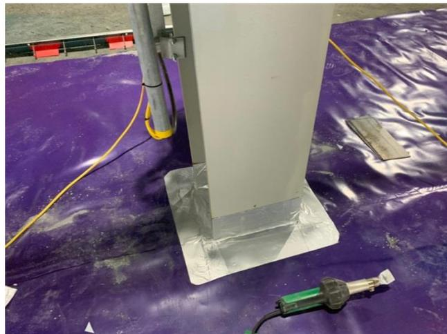
Figura 3.20 – Pormenor do reforço da membrana contra o radão na zona de atravessamento de uma coluna em aço<sup>9</sup>
