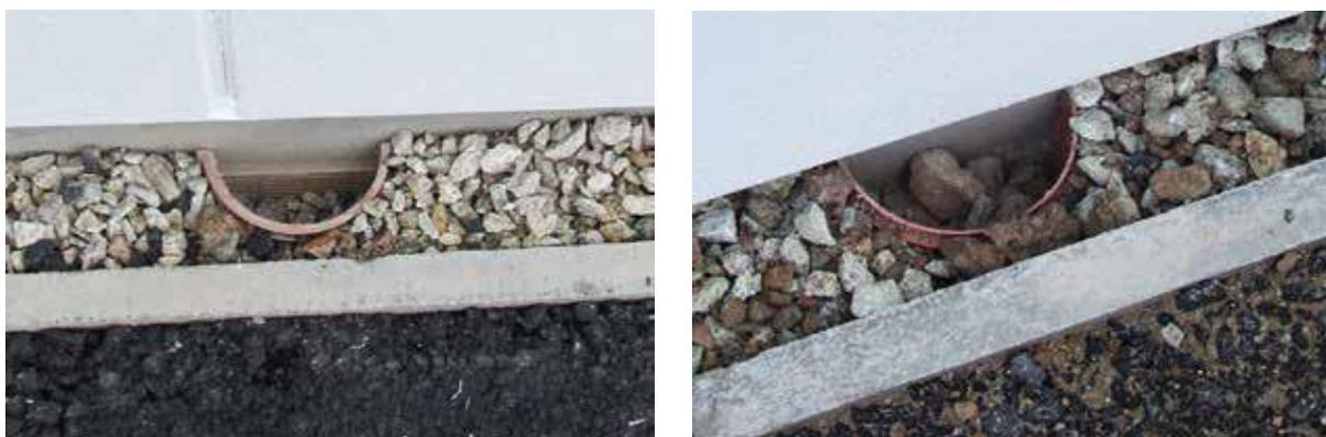
Figura A1.3 – Exemplos de aberturas de ventilação instaladas abaixo do nível do solo, parcialmente ou totalmente obstruídas<sup>11</sup>
