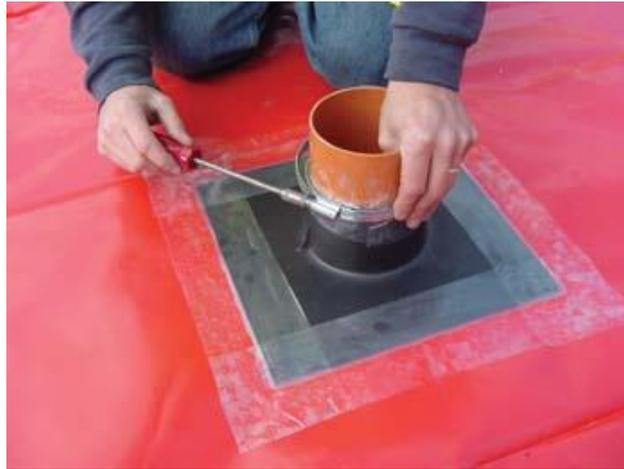
Figura 3.19 – Pormenor da vedação, com reforço da membrana sobre o pavimento, na zona de atravessamento de conduta de um sistema de aspiração instalado abaixo do pavimento<sup>8</sup>
