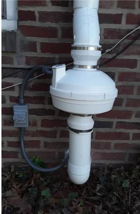
Figura AIV.4 – Ventilador centrífugo vertical típico, usado em sistemas de despressurização do terreno debaixo do pavimento<sup>17</sup>
