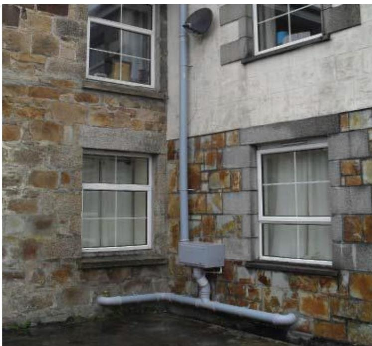
Figura AIV.2 – Fotografia de apartamentos independentes, com um sistema de despressurização comum composto por uma câmara de captação instalada em cada apartamento ligadas a um único ventilador e conduta de exaustão<sup>16</sup>
