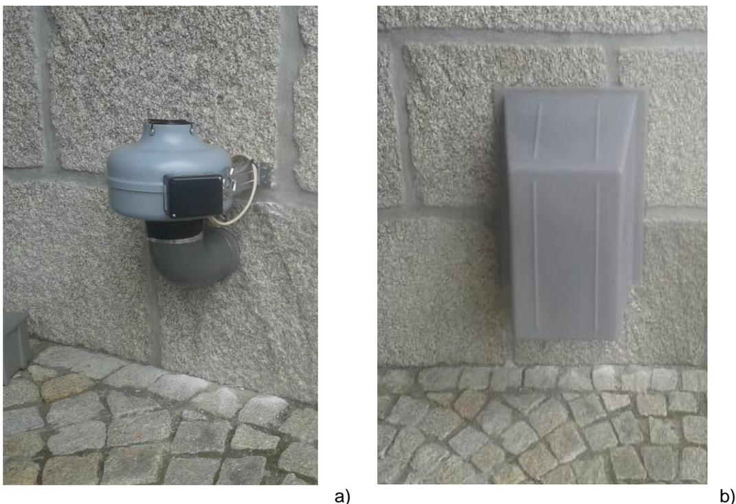
**Figura AIV.6 – Sistemas de exaustão típicos, com ventilador incorporado, usados em sistemas de despressurização do terreno debaixo do pavimento, construídos no exterior do edifício, com exaustão a nível térreo: a) antes da instalação da caixa de proteção; b) depois da instalação da caixa de proteção<sup>19</sup>**
