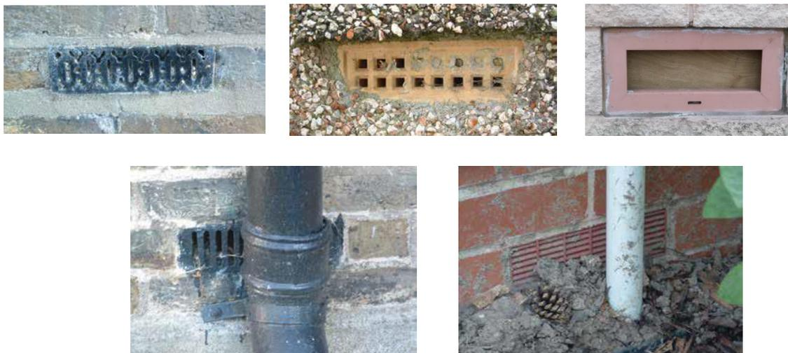
Figura A1.2 – Exemplos de aberturas de ventilação, construídas na parede, imediatamente acima nível do solo, bloqueadas ou obstruídas<sup>11</sup>
