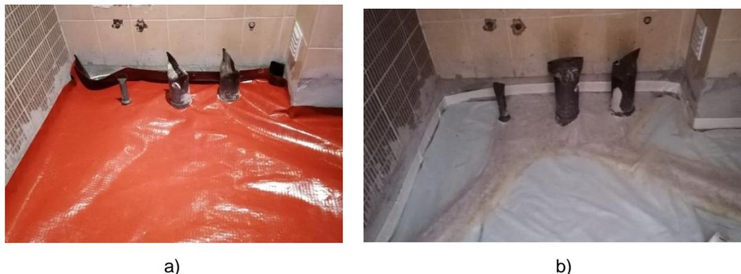
**Figura 3.18 – Membrana sobre um pavimento e respetivos remates com as paredes e tubagens (a); Tela geotêxtil de proteção da membrana contra o radão subjacente ilustrada em a) (b)<sup>7</sup>**
