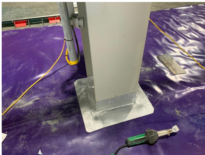
Figura 4.6 – Pormenor do reforço da membrana na zona de atravessamento de um pilar metálico
