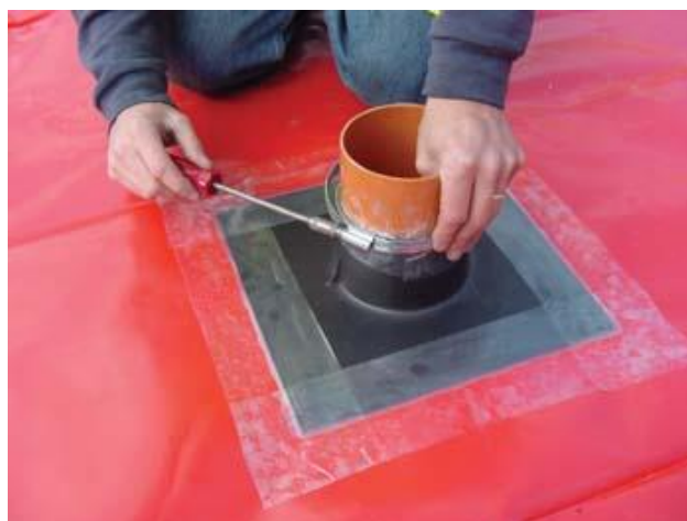
Figura 4.5 – Ilustração de pormenor do reforço da membrana na zona de atravessamento da conduta de um sistema de despressurização instalado abaixo do pavimento
