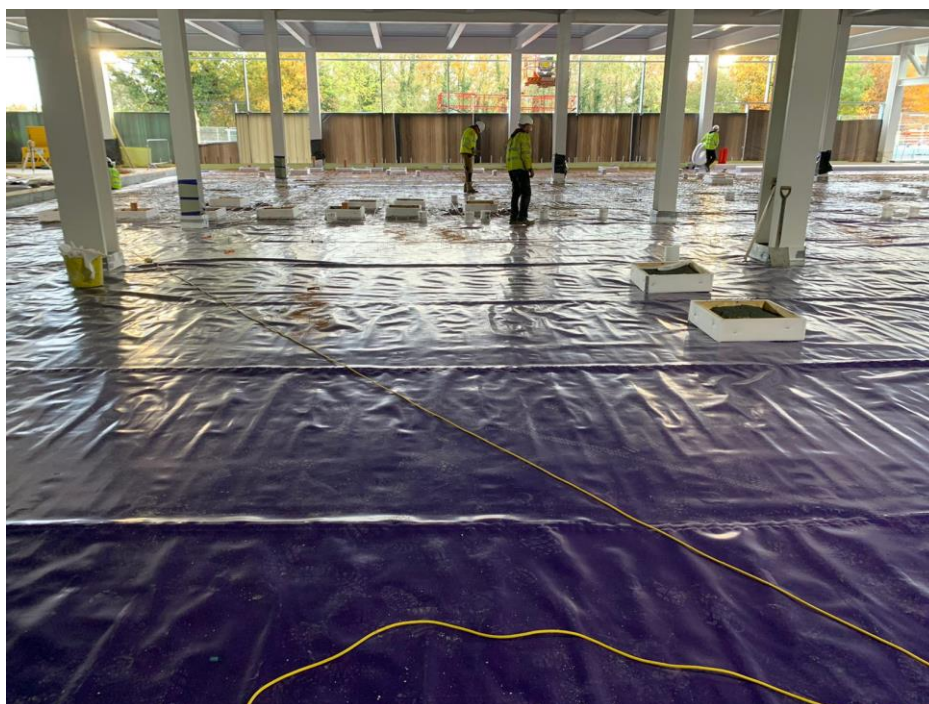
Figura 4.2 – Imagem da instalação de uma membrana de proteção ao radão num edifício em construção
