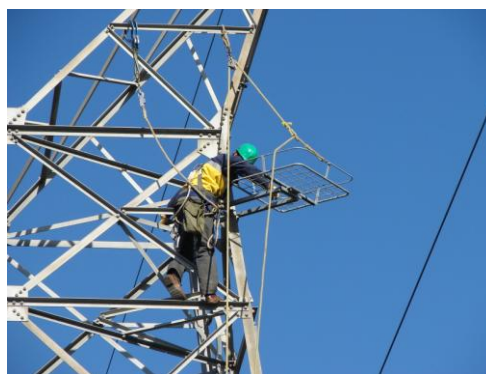
Figura 7 - Instalação de plataformas para nidificação
