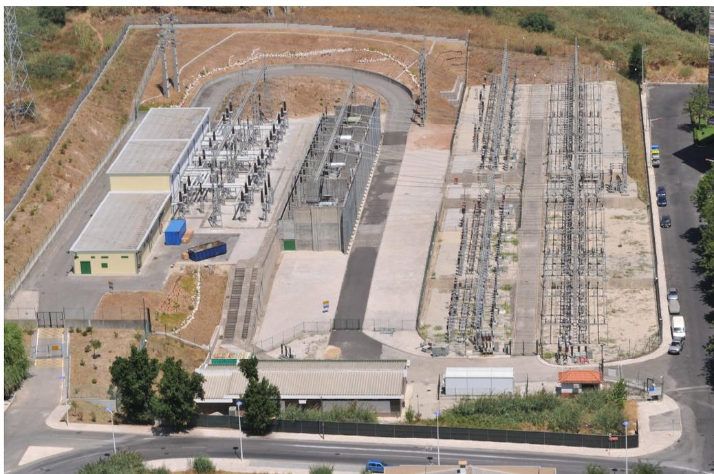
**Figura 4** - Subestação de Carriche (Blindada - Isolamento a SF<sub>6</sub>)
