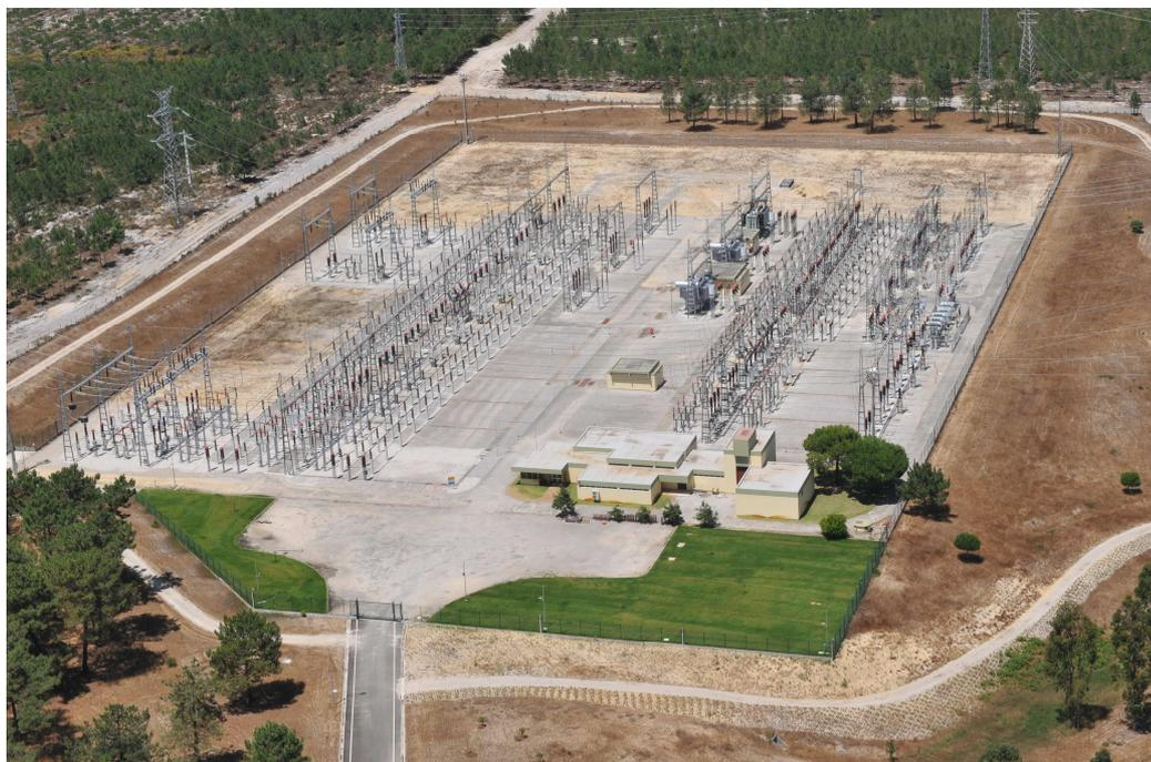
**Figura 3** - Subestação de Fernão Ferro (Tecnologia tradicional - Isolamento a ar)
