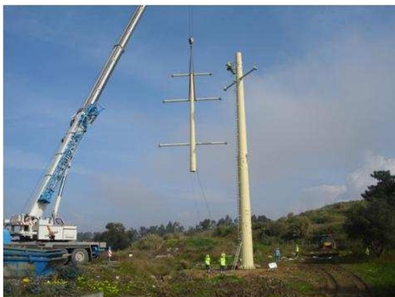
**Figura 6 - Poste tubular na linha Fernão Ferro - Trafaria 2 a 150 kV**
