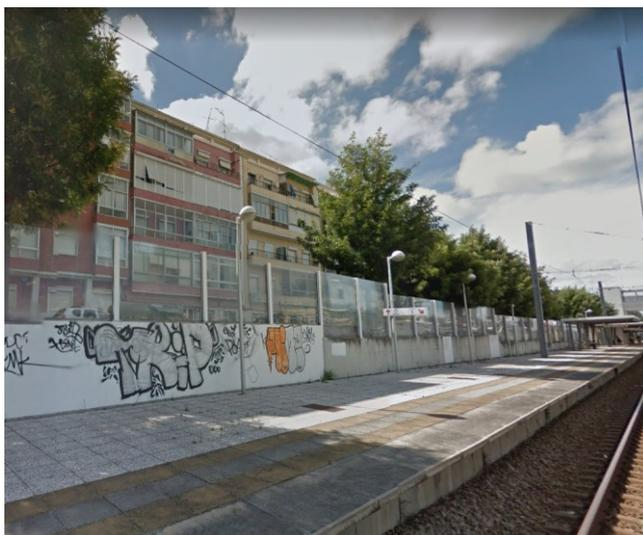
*Figura 28. Barreira Acústica na Estação de Moscavide, sentido ascendente.*
