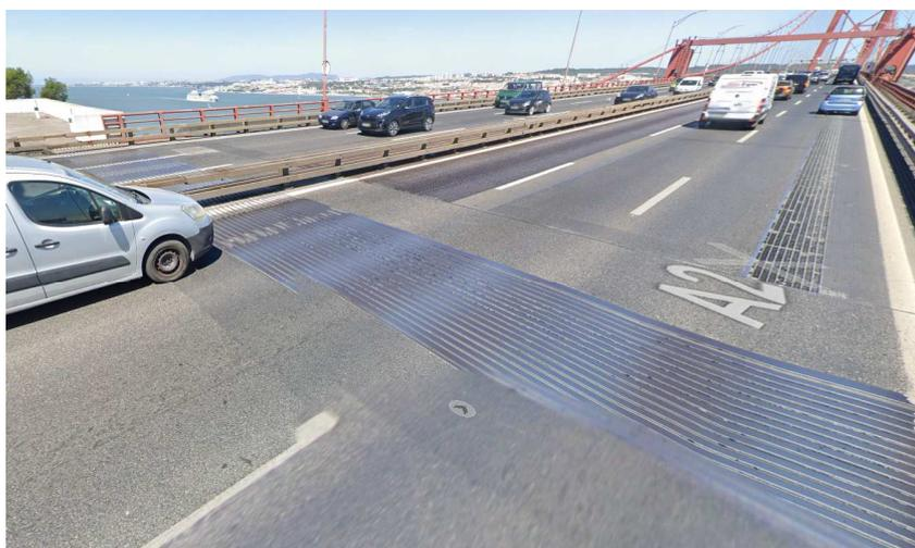
**Figura 3 – Exemplos de medidas de redução sonora instaladas na Ponte 25 de Abril**
