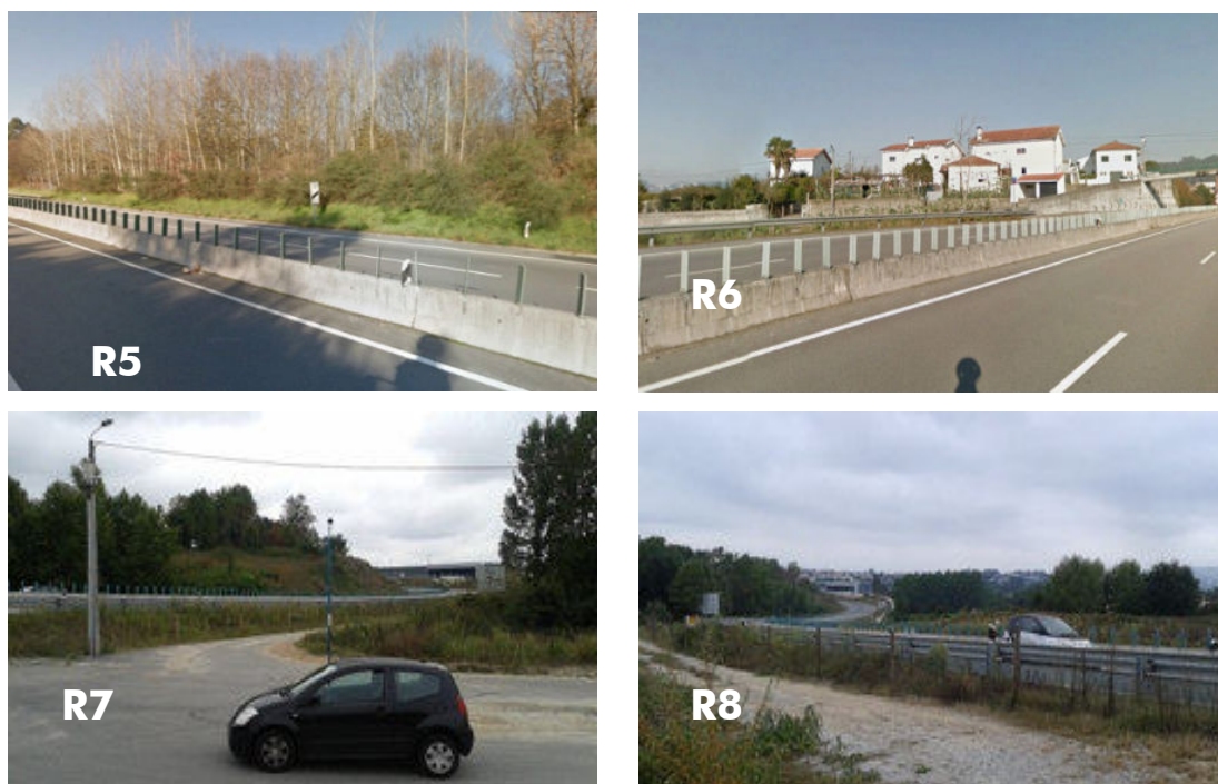
Figura 4 – Registo fotográfico e localização dos pontos de medição (R1, R2, R3, R4, R5, R6, R7 e R8)
