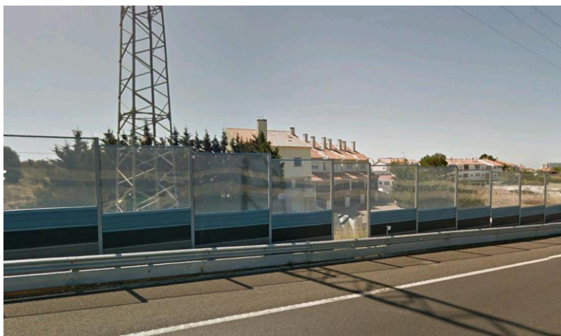
Figura 4-3 – Exemplos de barreiras acústicas de diversos tipos instaladas na A16.
