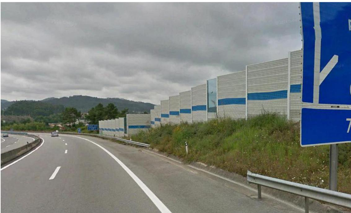
**Imagem 2: Barreira Metálica e acrílica**
