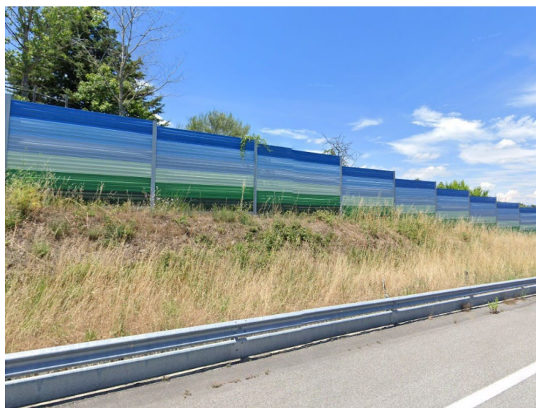
Figura 3: Barreira metálica, localizada entre o km 106+459 e o km 106+680, no sentido decrescente.
