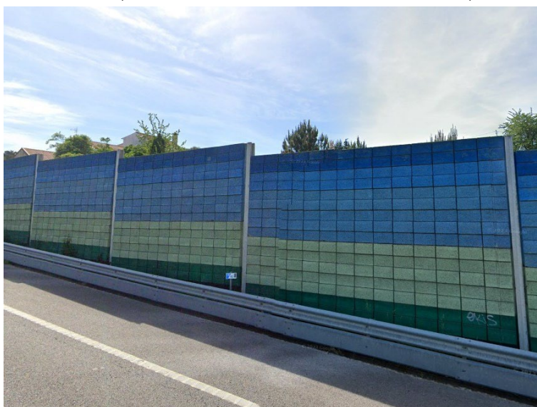
Figura 5: Barreira de Betão, localizada entre o km 93+760 e o km 93+872, no sentido crescente.
