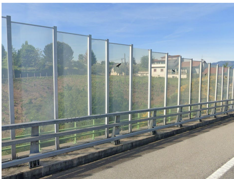
Figura 4: Barreira de Acrílico, localizada entre o km 93+872 e o km 93+938, no sentido crescente.
