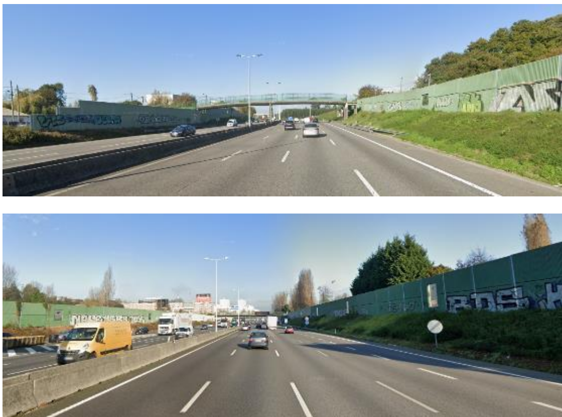
Fig. 4 - Exemplos de barreiras acústicas instaladas na A3
