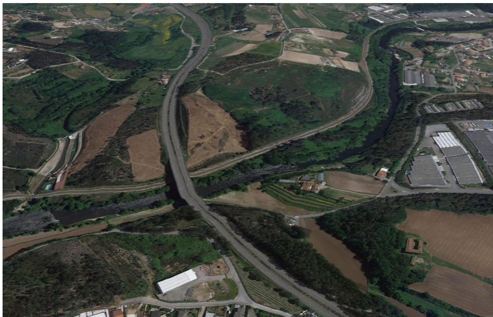
Viaduto do rio de ave ao pk 23+000
