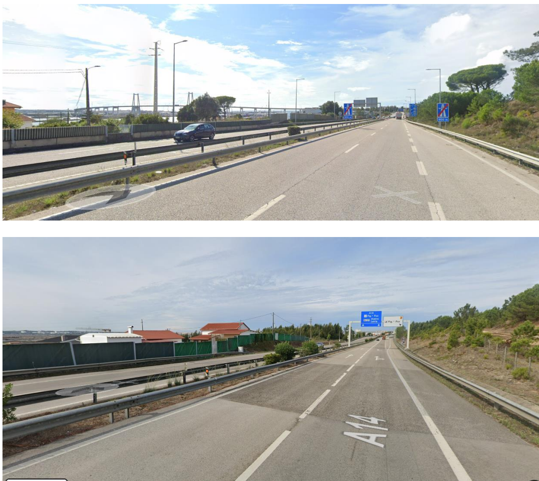
Fig. 4 - Exemplos de barreiras acústicas instaladas na A14
