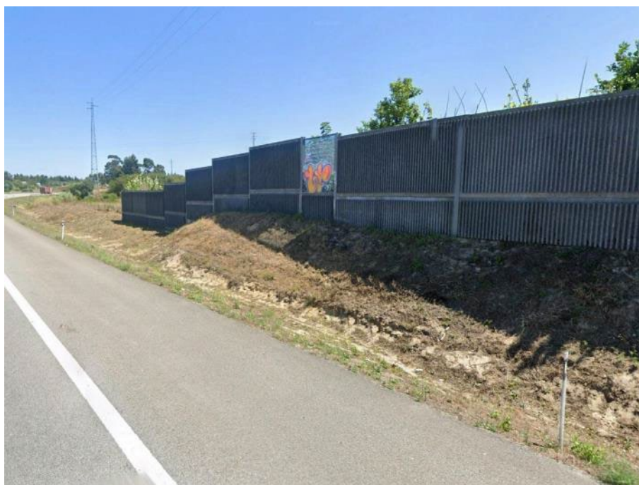
Figura 7: Barreira de Betão.
