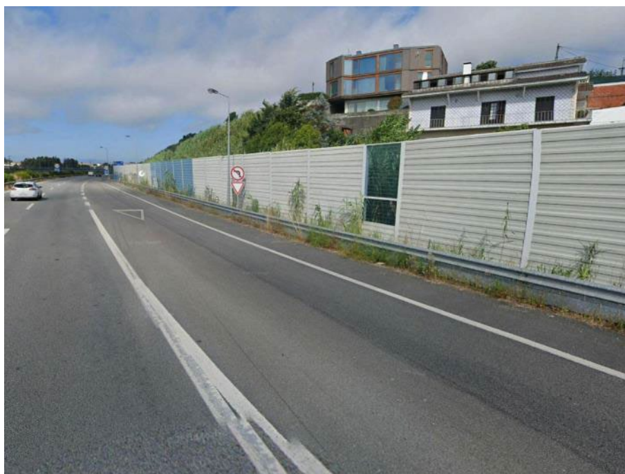
Figura 5: Barreira metálica com acrílico.
