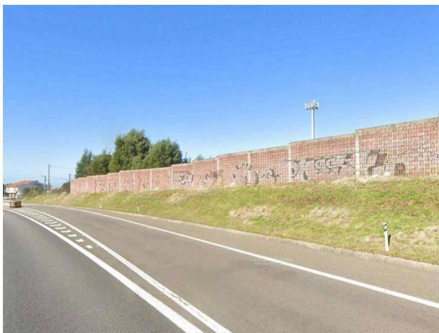
Figura 6: Barreira de Blocos.
