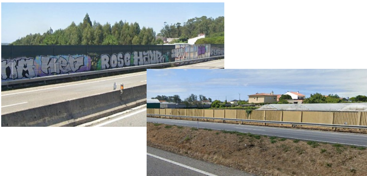
Figura 1 – Exemplos de barreiras acústicas de diversos tipos instaladas na A28
