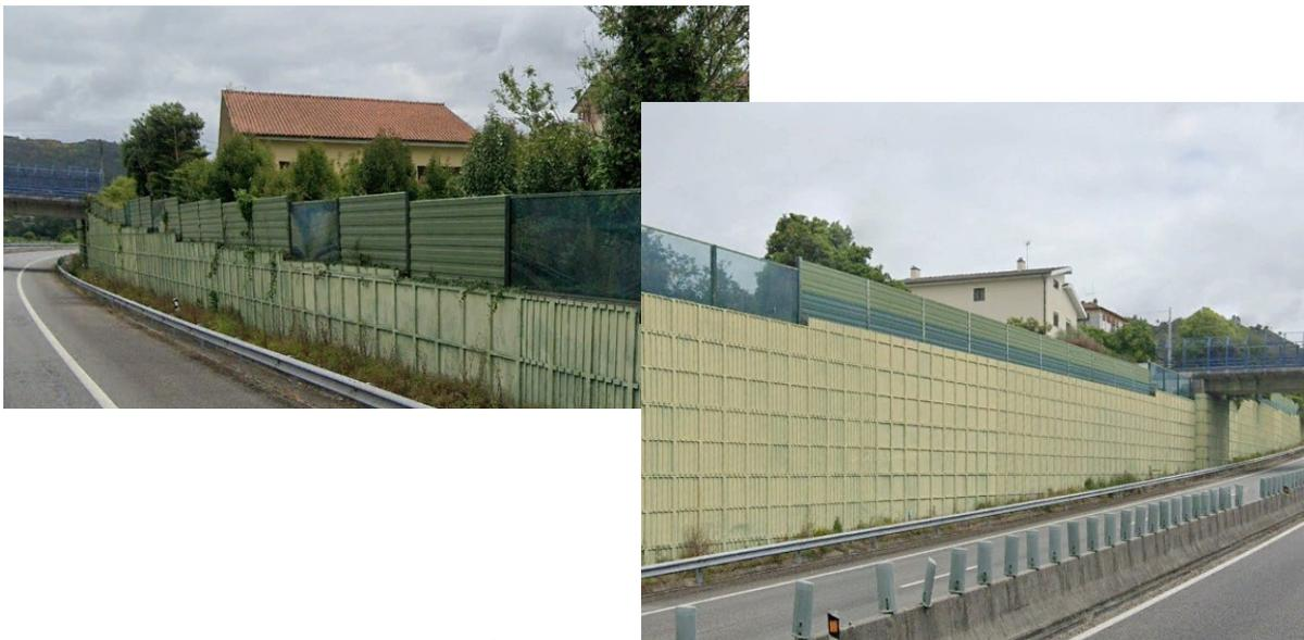
**Figura 4-1 – Exemplos de barreiras acústicas de diversos tipos instaladas na A27**
