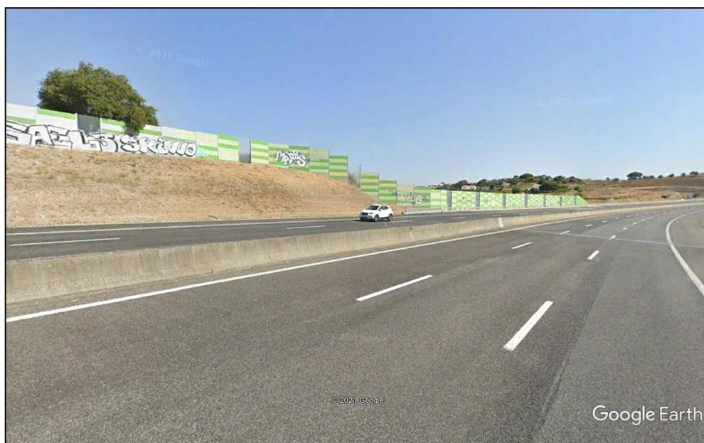
**F Figura 3 – Exemplo de barreiras acústicas instaladas ao longo da A10**
