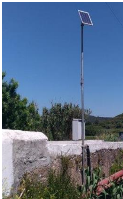
Figura 46 - Estação Hidrométrica de Runa
