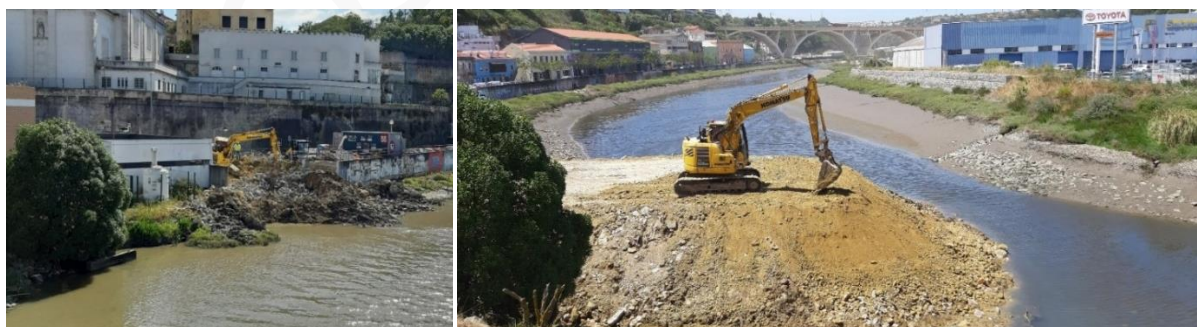
Figura 47 - Execução da ensecadeira no âmbito da medida PTTJLoures_PROT46_RH5
