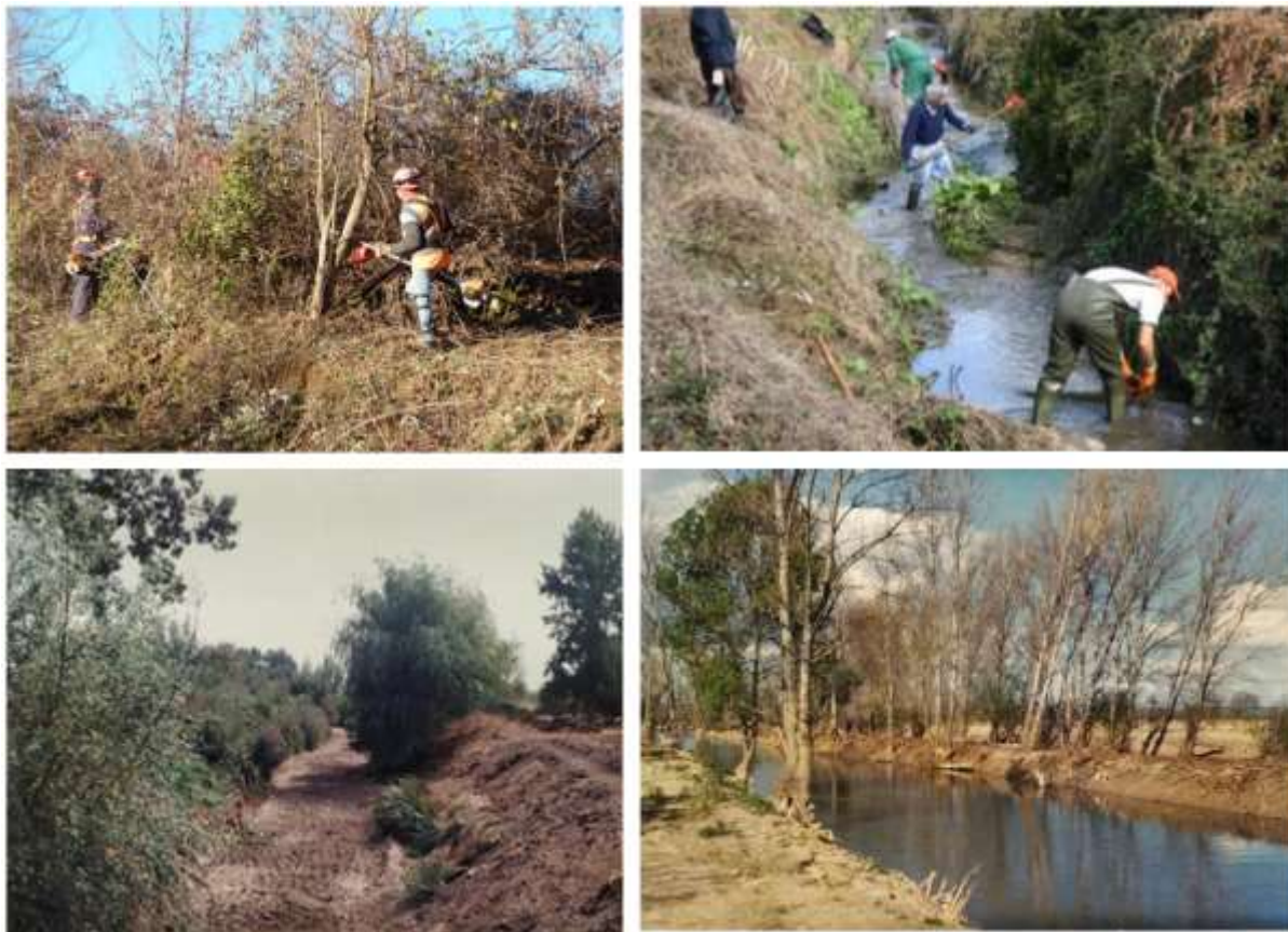
Figura 30 - Realização de ações de limpeza no âmbito da medida PT_PROT1_NAC
