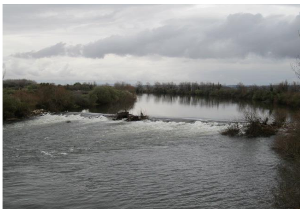
Açude de Formoselha (antes de implementada a passagem para peixes)
