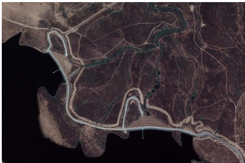
Figura 3 Infraestrutura Hidráulica com DLCE
