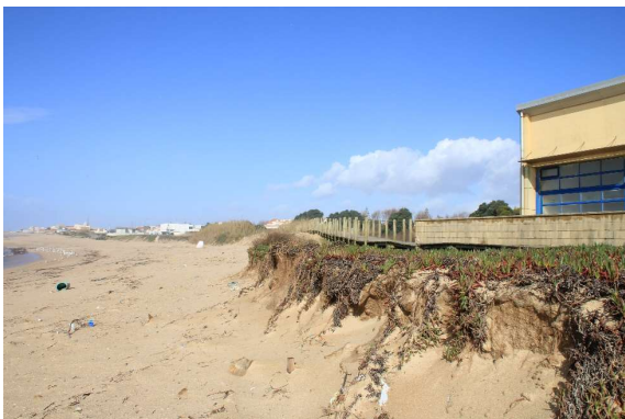
Degradação dunar em Vila Nova de Gaia (Fonte: APA/ARH Norte)
