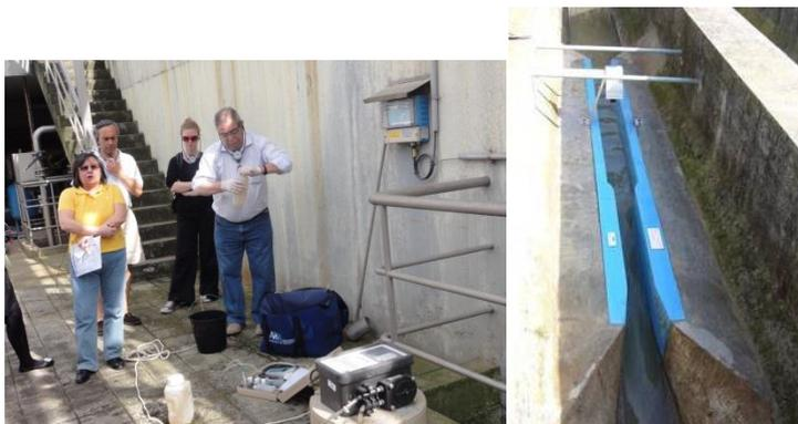
Fiscalização de autocontrolo de águas residuais (Fonte: APA, I.P) e Medidor de caudal de águas residuais, associado ao canal Venturi
