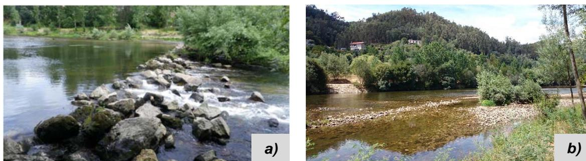
**Figura 13. Açude da Ronqueira, antes (a – vista margem direita) e depois (b – vista da margem esquerda) da sua remoção.**
