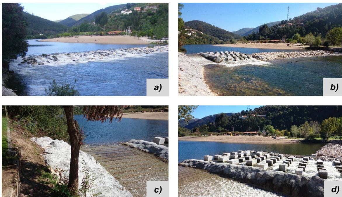
**Figura 7. Açude de Palheiros, antes (a) e depois (b) das intervenções realizadas. Pormenor da (c) passagem para caiaques e (d) da rampa para peixes.**
