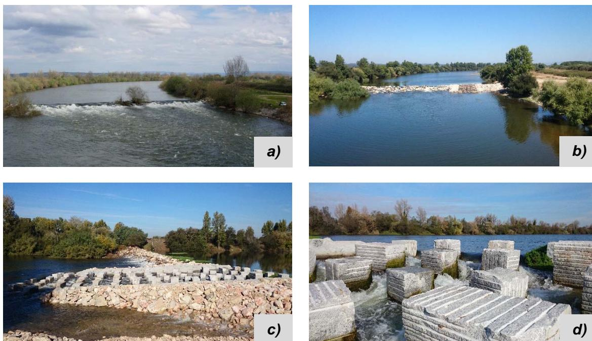
**Figura 4. Açude da Formoselha, antes (a) e depois (b) da intervenção realizada. Pormenor da (c) rampa para peixes e (d) e da disposição dos blocos utilizados para reduzir a velocidade de escoamento.**
