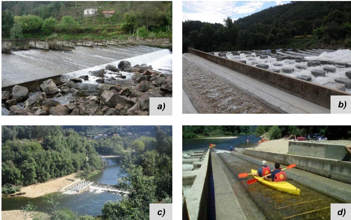
Figura 10. Açude de Louredo, antes (a) e depois (b) das intervenções realizadas. Vista aérea (c) e pormenor da rampa para caiaques, fotografia tirada pela empresa de canoagem “O Pioneiro do Mondego” (d).
