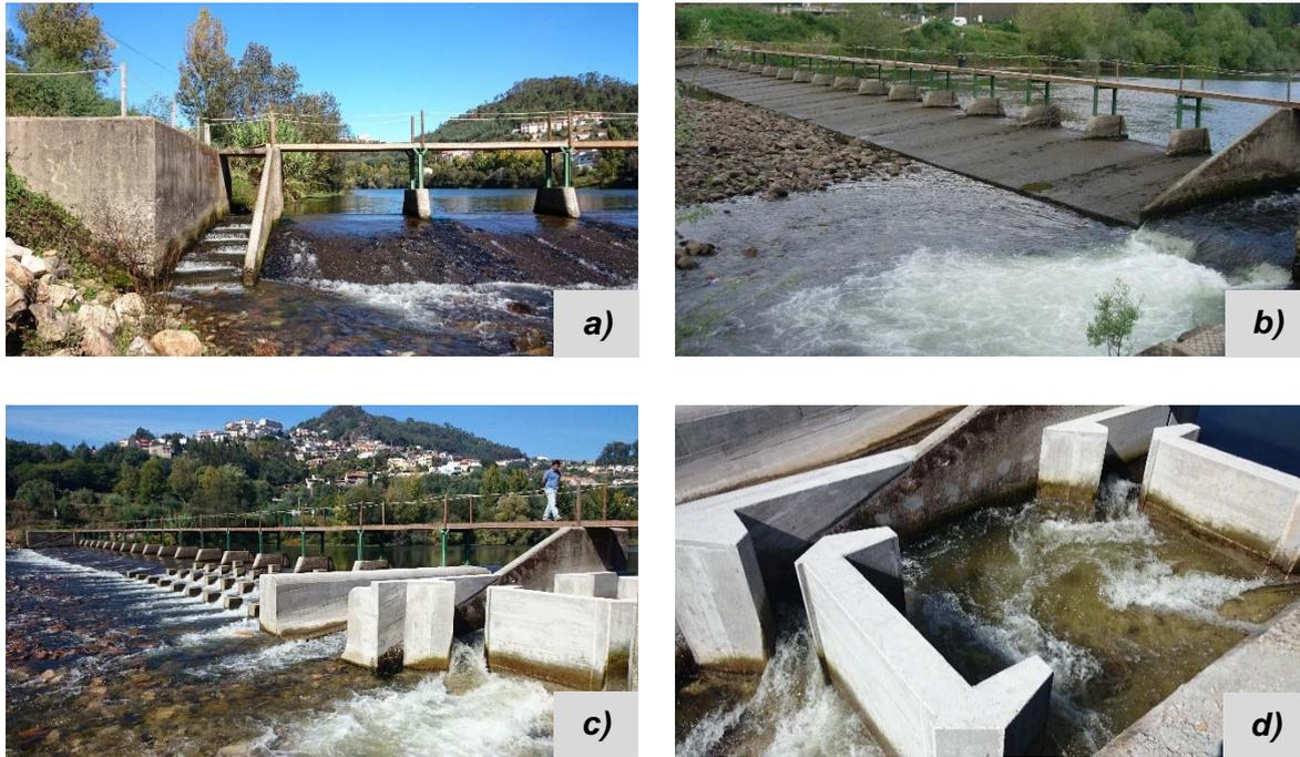
**Figura 14. Açude do Reconquinho, (a) pormenor da antiga passagem para peixes (vista margem direita); açude antes (b) e depois (c) das intervenções realizadas (vista margem direita) (d) pormenor da bacia da passagem para peixes técnica.**
