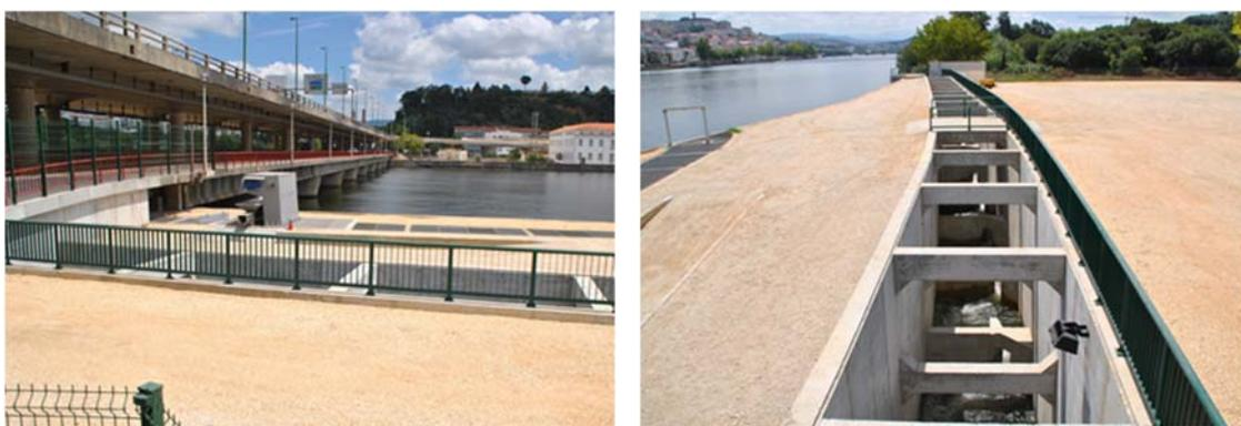
**Figura 38. Passagem para peixes do Açude-Ponte de Coimbra.**
