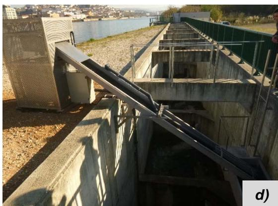
**Figura 20. Passagem para enguias construída no Açude-Ponte de Coimbra: a) vista da entrada da passagem, a jusante; b) rampa de cerdas e bacia nº3; c) juvenil de enguia a reptar pela caleira de cerdas, d) abrigo de monitorização.**
