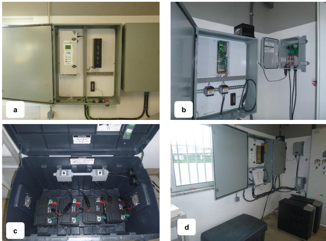
Figura 49. Pormenores do trabalho realizado no interior da sala de monitorização da PPPeixes: a) controlador geral do sistema IS1001MC; b) quadro de proteção IS1001 e quadro que regula o funcionamento do Battery Switcher ; c) conjunto de baterias de 12V e d) disposição dos vários componentes que constituem o sistema.
