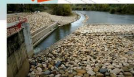
ENTRADA DA PASSAGEM PARA PEIXES A JUSANTE
