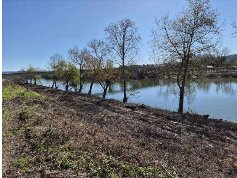
Figura 4.21 – Árvores de grande porte no talude entre o leito menor e o leito maior
