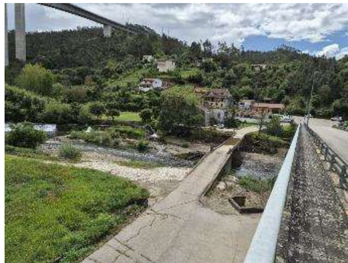
Figura 4.10 – Situação a montante da nova ponte sobre o rio Ceira, na Boiça
