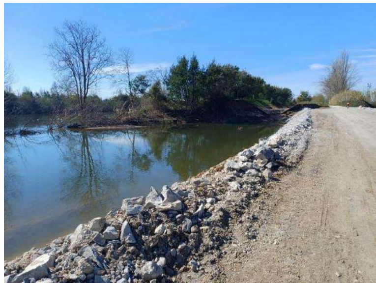
Figura 4.22 – Densa arborização no leito central
