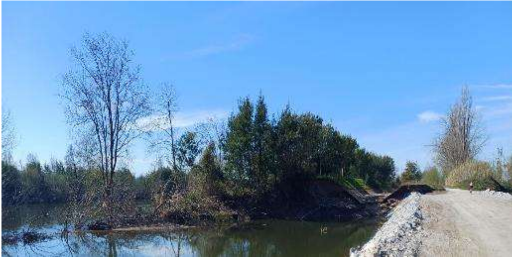
Figura 4.15 – Aspeto atual do dique imediatamente a jusante da A1
