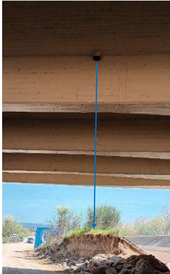
Figura 4.19 – Tubo de queda da ponte da A1.
