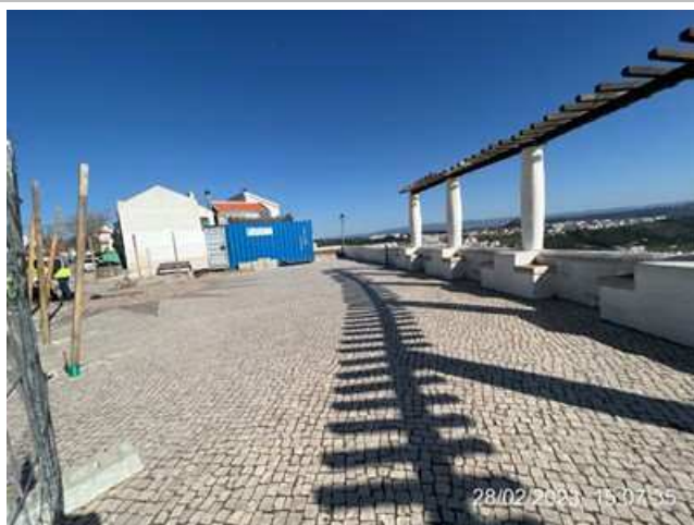
Montagem de vedação do estaleiro de obra;
