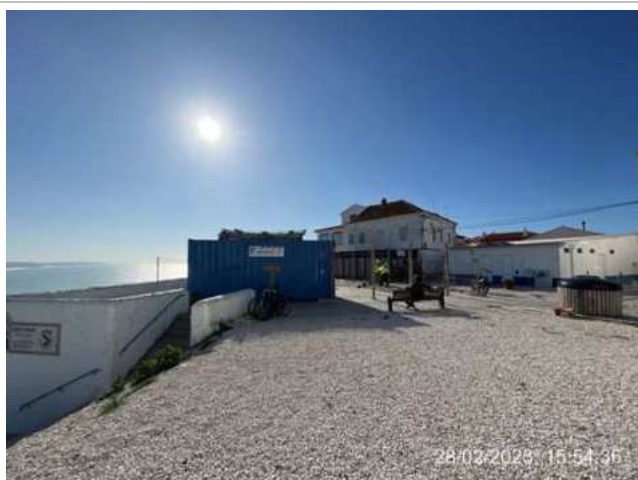
Montagem de vedação do estaleiro de obra;
