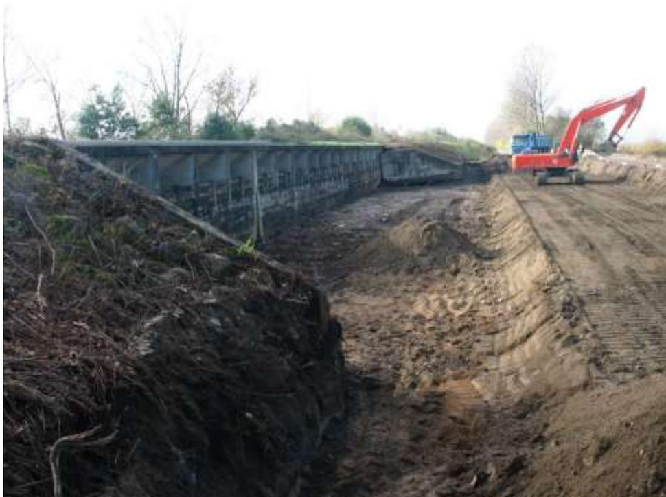
**Escavação na saída do descarregador ECC2 para colocação da estrutura de proteção da descarga, em gabiões**
