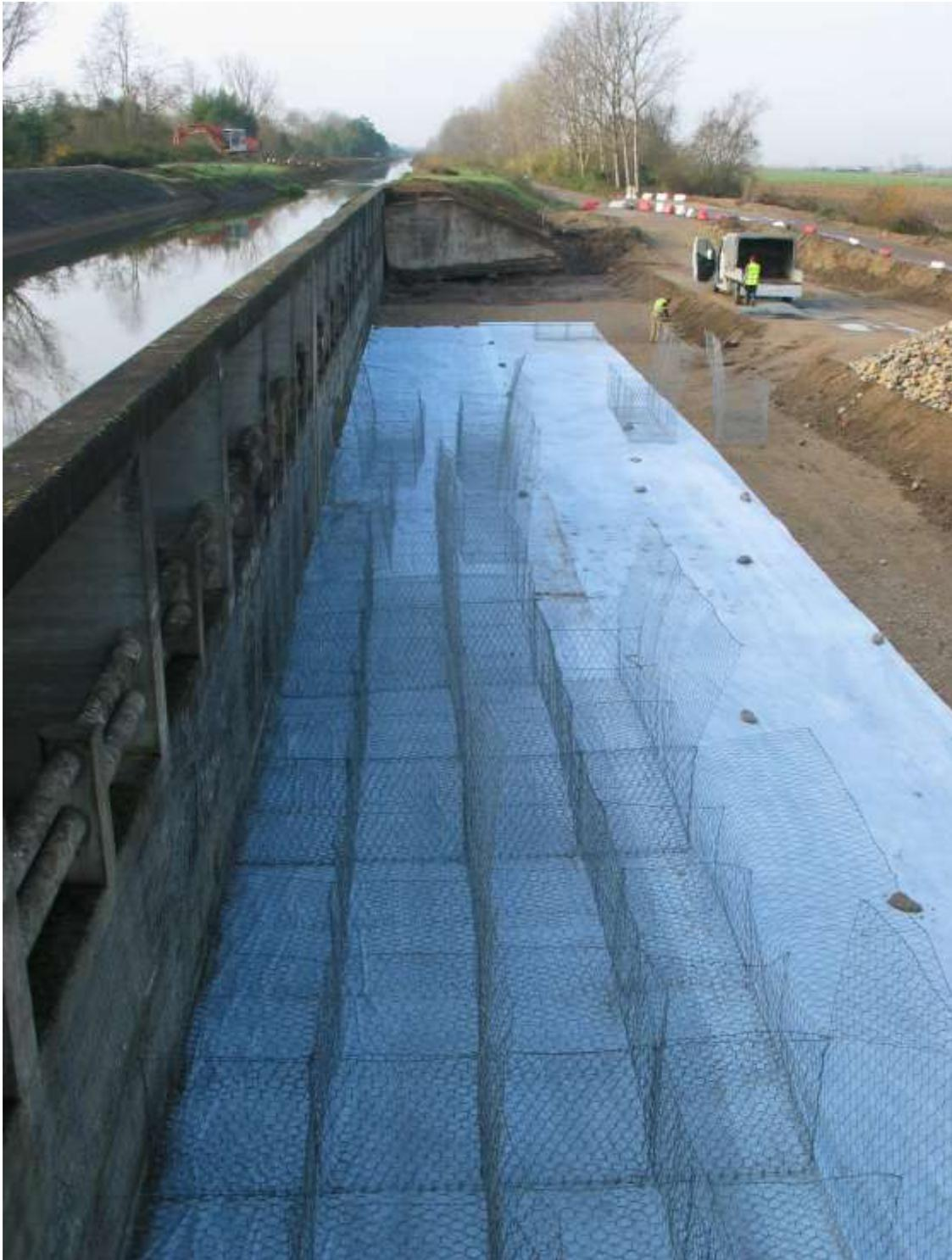
**Estrutura de proteção do descarregador ECC2 – Colocação de geotêxtil e início da montagem das caixas em rede de aço para execução de gabiões**
