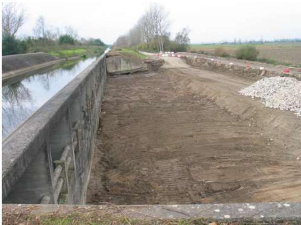
**Idem. Escavação concluída e fornecimento do enrocamento para construção dos gabiões**
